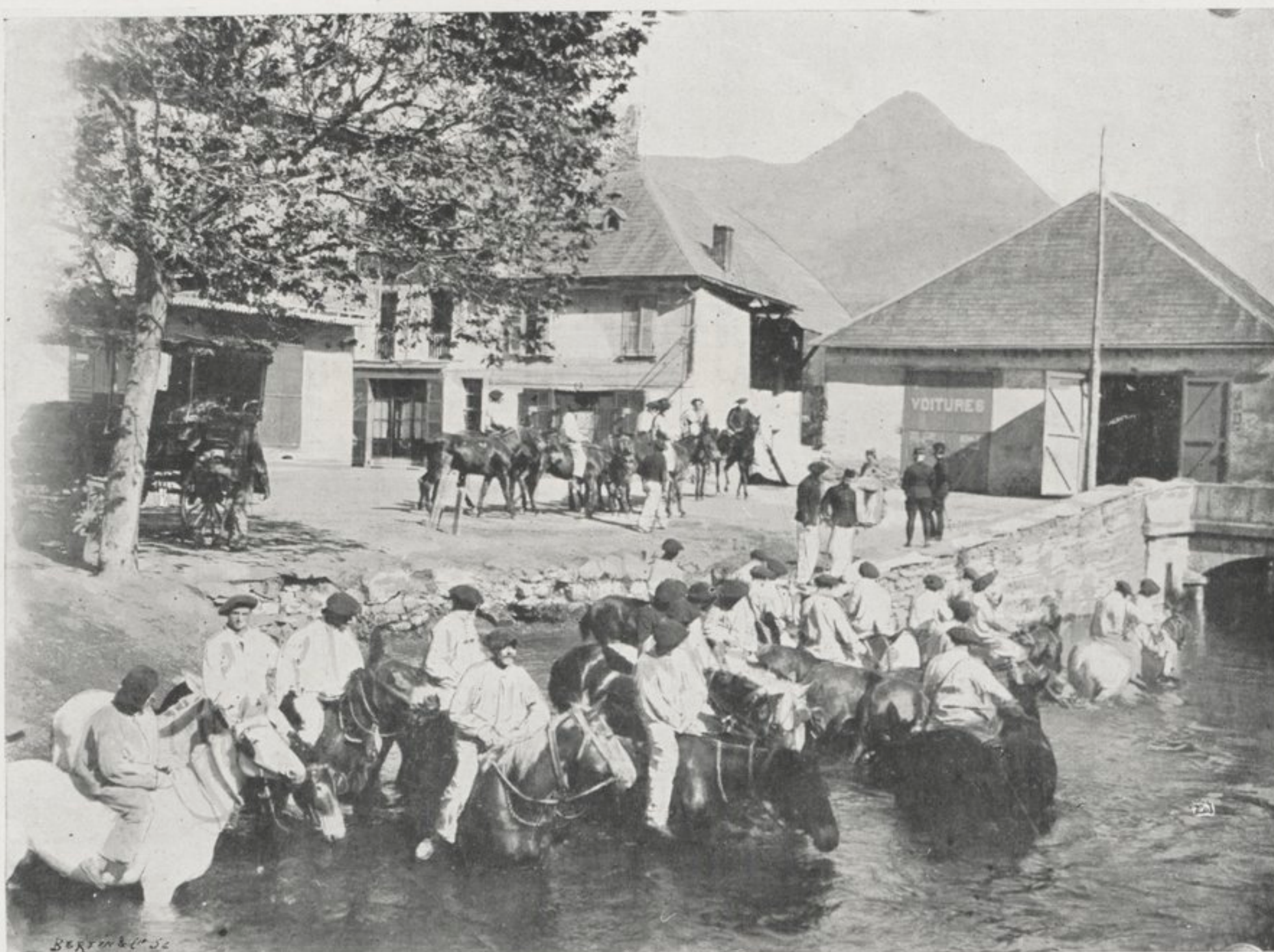
L'ABREUVOIR D'UNE BATTERIE ALPINE CANAL DE LA ROMANCHE A BOURG D'OISANS (ISÈRE)
